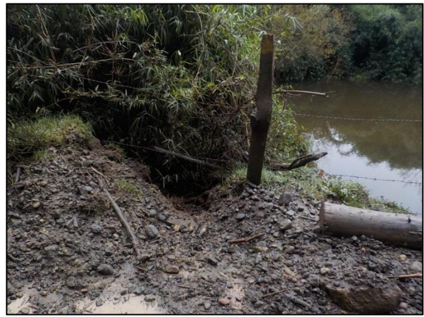
Foto 8. Desagüe del camino público, ej. 2.
