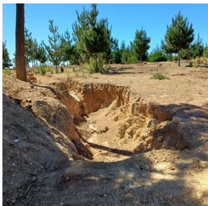
Foto 12. Zanja en el ingreso de AAVC.
