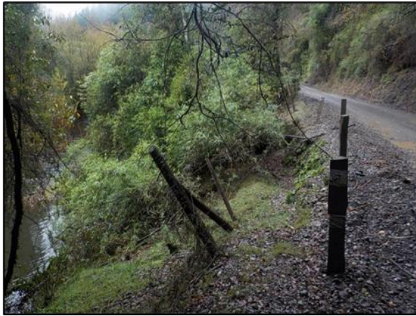
Foto 7. Desagüe del camino público, ej. 1.
