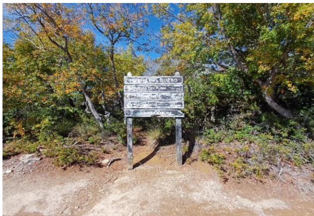
Foto 19. Letrero en mal estado.
