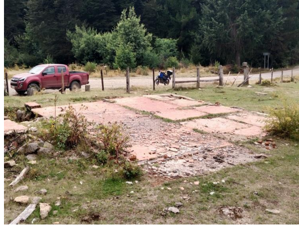
Foto 16. Restos de construcción dentro del AAVC, ej. 2.
