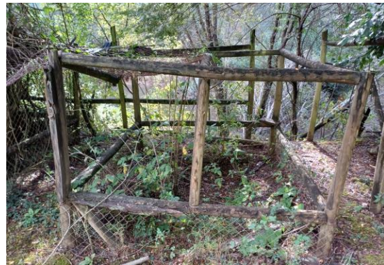
Foto 22. Instalaciones en desuso en AAVC, ej. 2.
