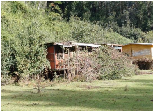
Foto 21. Instalaciones en desuso en AAVC, ej. 1.
