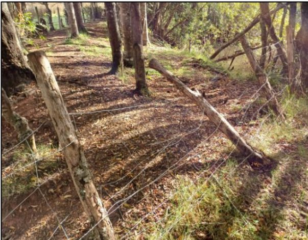
Foto 5. Cerco dañado monitoreo anterior.
