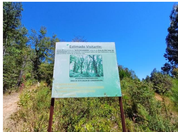
Figura 15. Letrero en mal estado, ej. 2.
