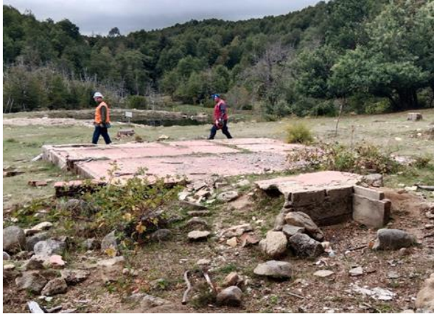
Foto 15. Restos de construcción dentro del AAVC, ej. 1.
